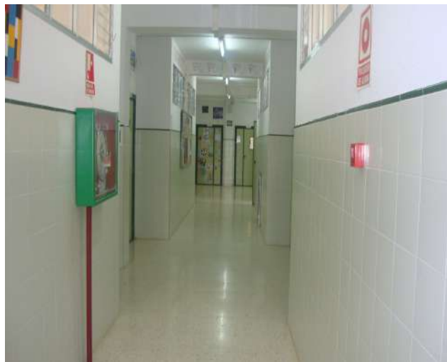
DISTRIBUIDOR P1 EN AULAS DE PRIMARIA (3º-4º-5º-6º-AULAS PLASTICA-MÚSICA ETC.)
