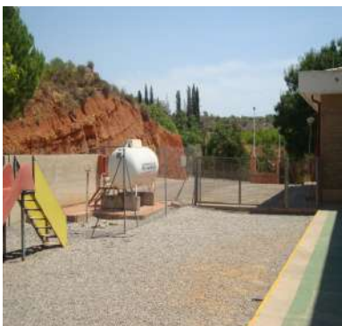
SEPARACIÓN DEPOSITO RESPECTO EDIFICACIÓN (CUMPLE)
