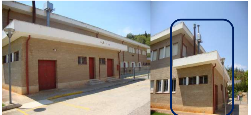
SALA CALDERA – COCINA
