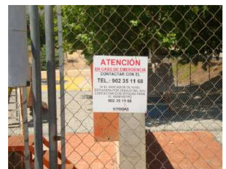
SEÑALIZACIÓN EMERGENCIA DEL TIPO DE GAS Y DATOS EN CASO EMERGENCIA EMPRESA SUMINISTRADORA
