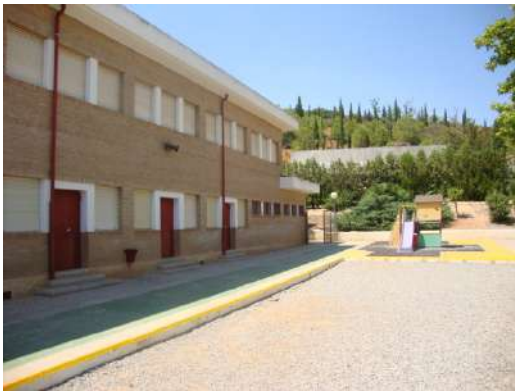
FACHADA LATERAL ORIENTACIÓN NORTE
