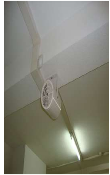
MEGAFONIA EN PB Y P1 INTERIOR
