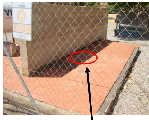
DEPOSITO DE GASOIL SUBTERRANEO
