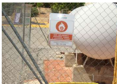
SEÑALIZACIÓN EMERGENCIA DEL TIPO DE GAS Y DATOS EN CASO EMERGENCIA EMPRESA SUMINISTRADORA
