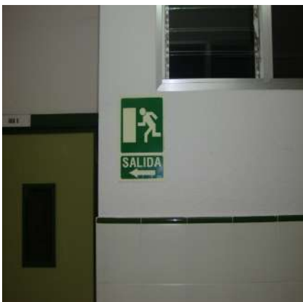
SEÑAL RECORRIDO EVACUACIÓN A SALIDA EMERGENCIA MÁS PRÓXIMA
