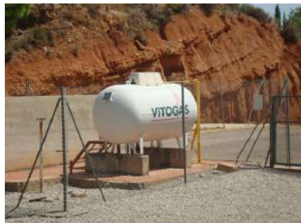
DEPOSITO EXTERIOR GAS BUTANO PARA ALIMENTACIÓN DE COCINA
