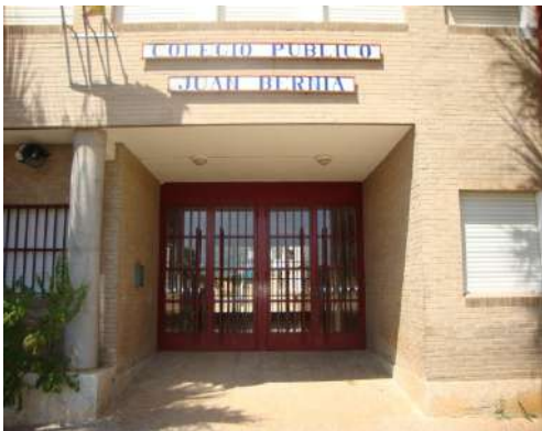
PUERTA ACCESO EDIFICIO-SALIDA EMERGENCIA SE-1
