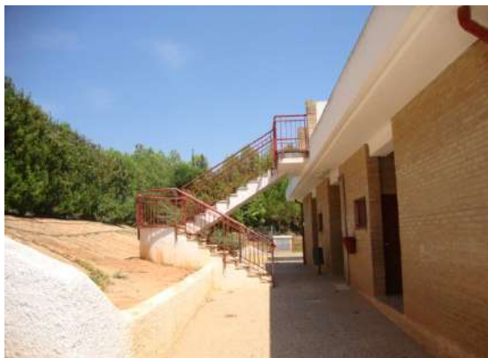
ESCALERA EVACUACIÓN EXTERIOR DESCENDENTE DE P1 A PB
